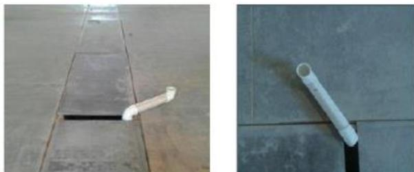
**A utilização de ponto de deságue para fornos combinados ou similares será permitida, desde que a saída de água não ultrapasse a temperatura máxima de 70°C para evitar deformação e vazamento durante a realização.**
